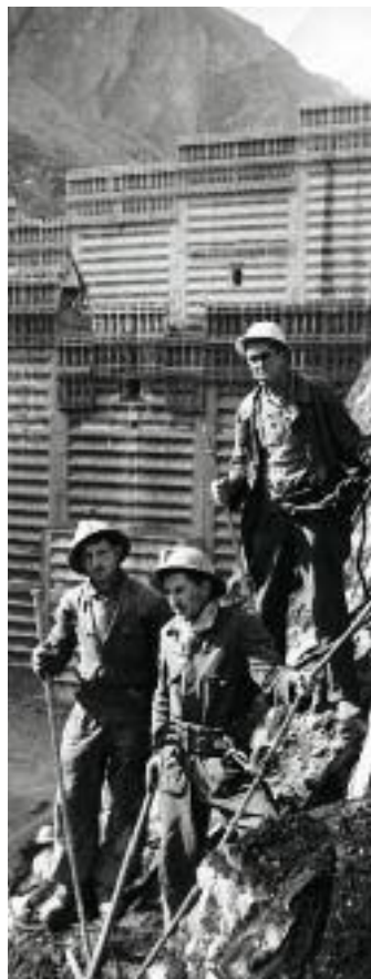
Fouilles du barrage en 1956
