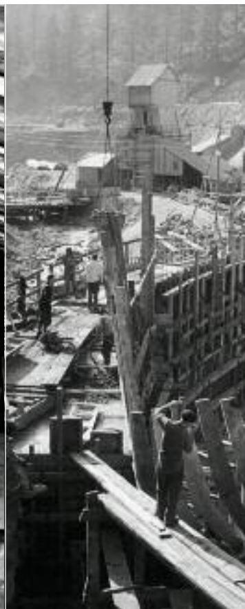
Coffrage et bétonnage du barrage de Serra en 1951
