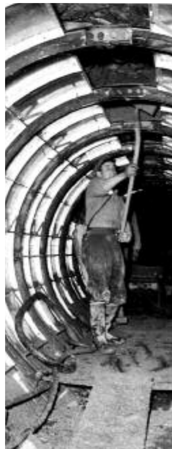
Bétonnage de la galerie d'amenée Serra - Gondo en 1951
