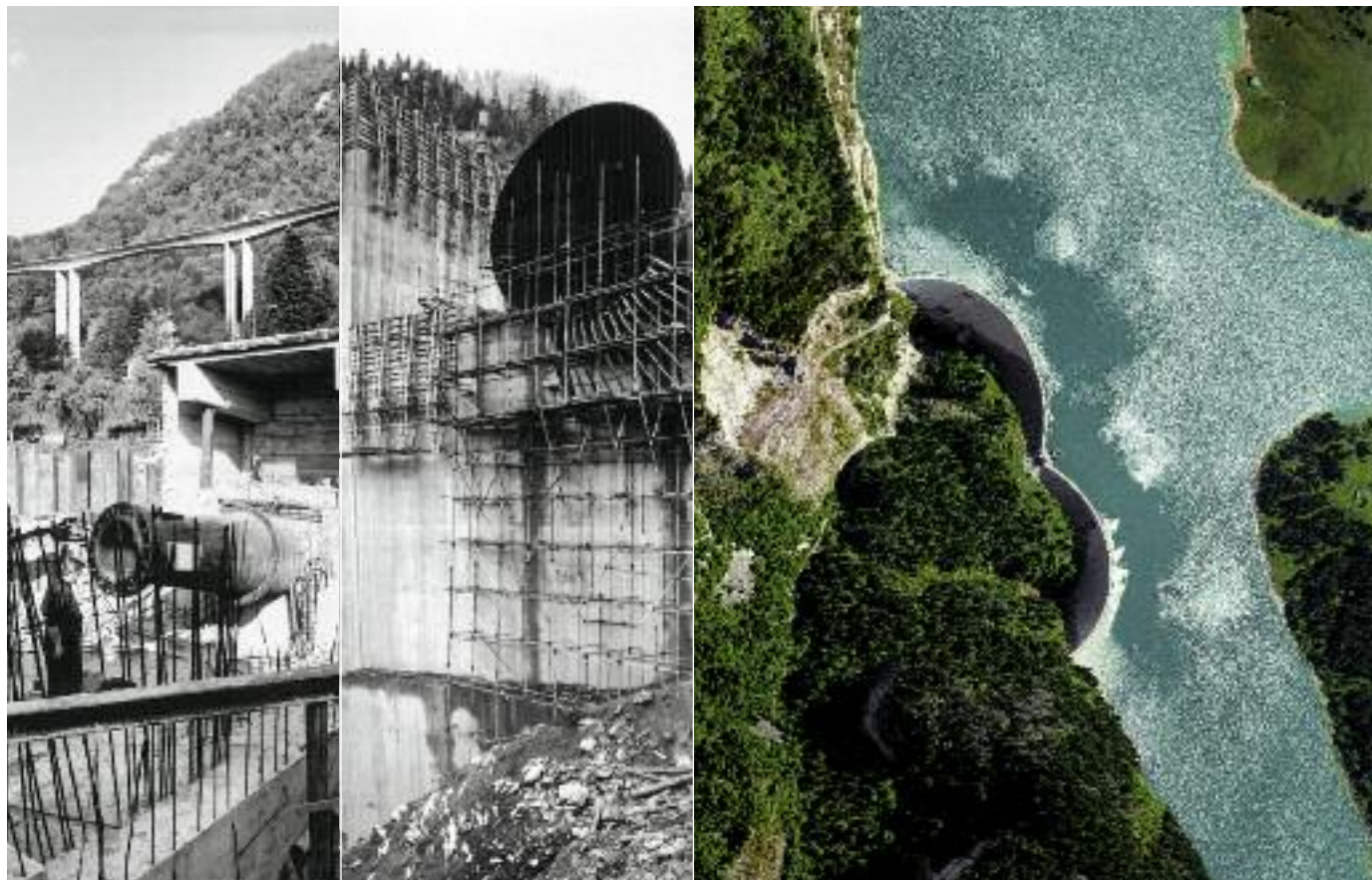
Veytaux : construction de la vanne à jet-creux Léman dans les années septante
